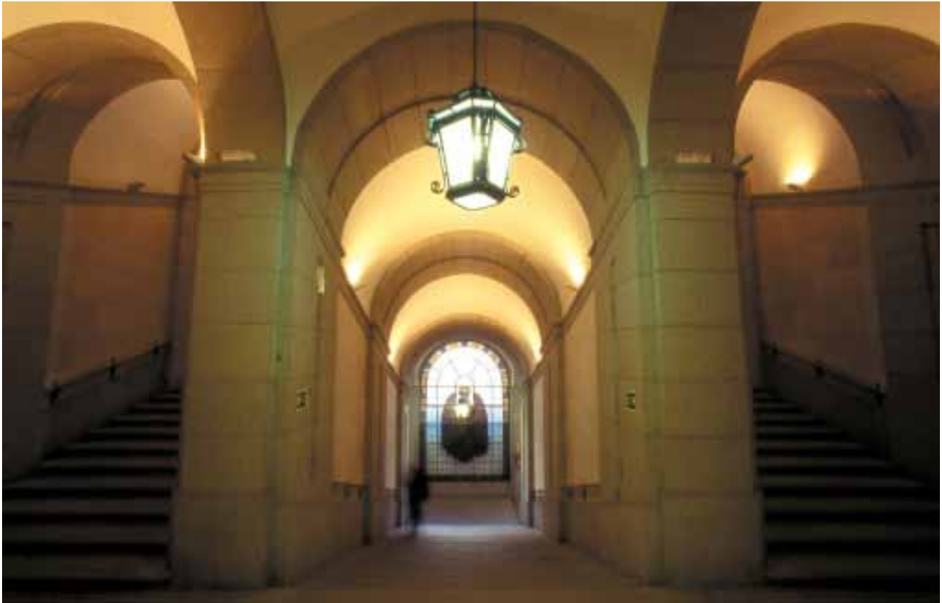
El doble ramal de la escalera en la primera planta.
