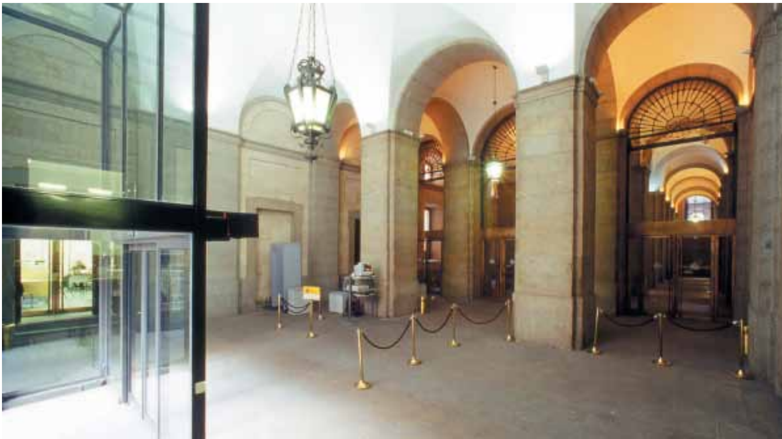
El vestíbulo: tres naves separadas por gruesos pilares de granito.
